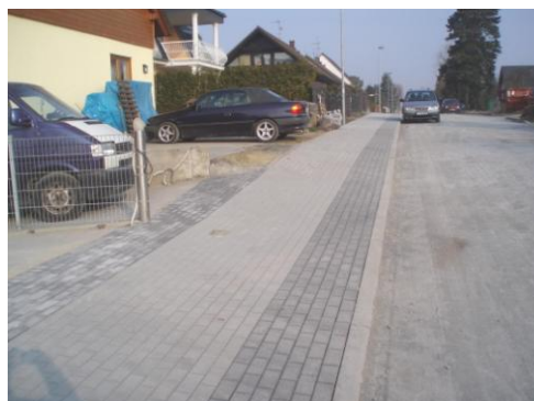
Nach der Baumaßnahme: Rosa-Luxemburg-Straße
